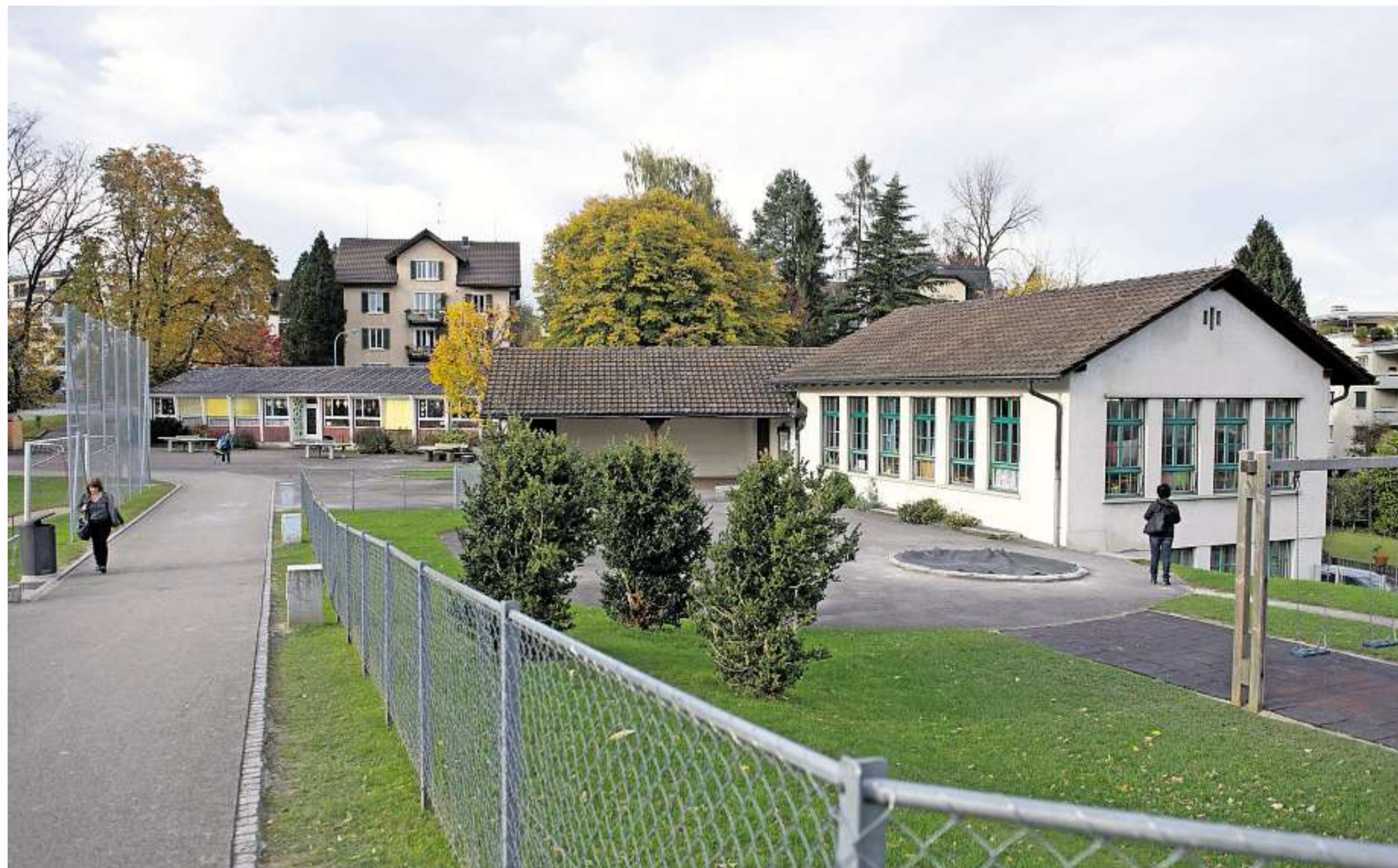
Die «Providurien» auf der Schulanlage Glärnisch sollen durch Neubauten ersetzt werden.
